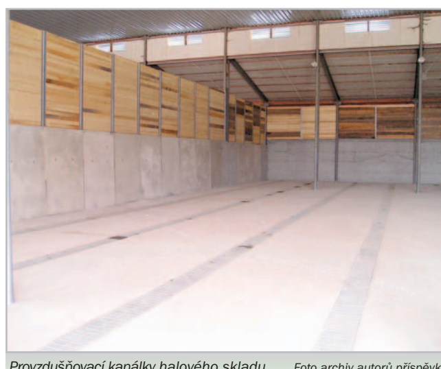
Provzdušňovací kanálky halového skladu
