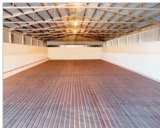
Provzdušňovací podlaha halového skladu Foto archiv autorů příspěvku
