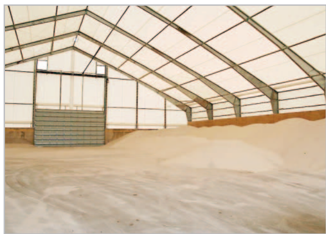
Interiér halového skladu
