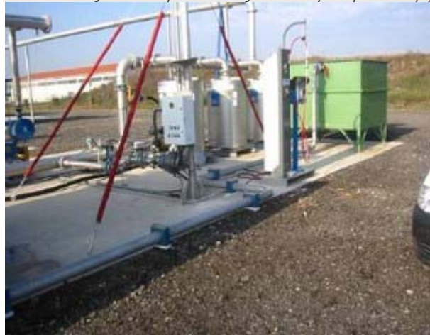
Obr. 3: Odsiřovací jednotka a výdejní stojan
