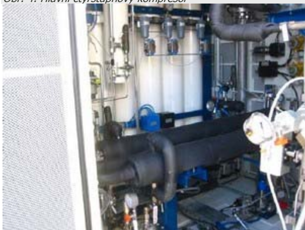
Obr. 5: Molekulová síta a tlakový zásobník
