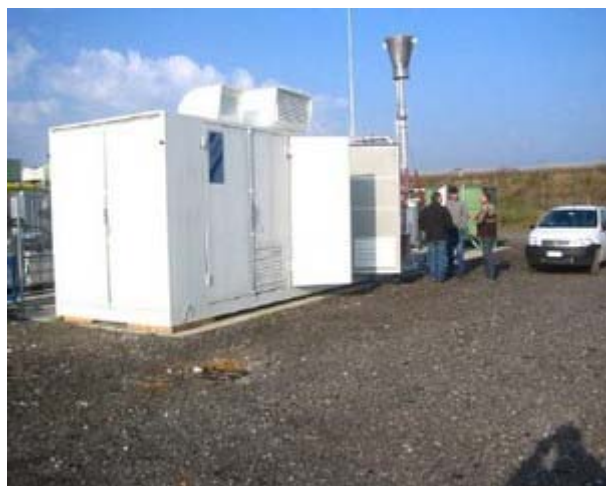
Obr. 2: Kontejner s kompresorovou jednotkou pro úpravu bioplynu
