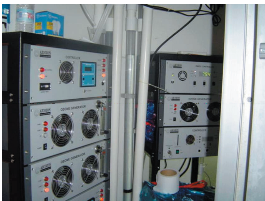
Obr. 3: Sestava zařízení ozonových generátorů
