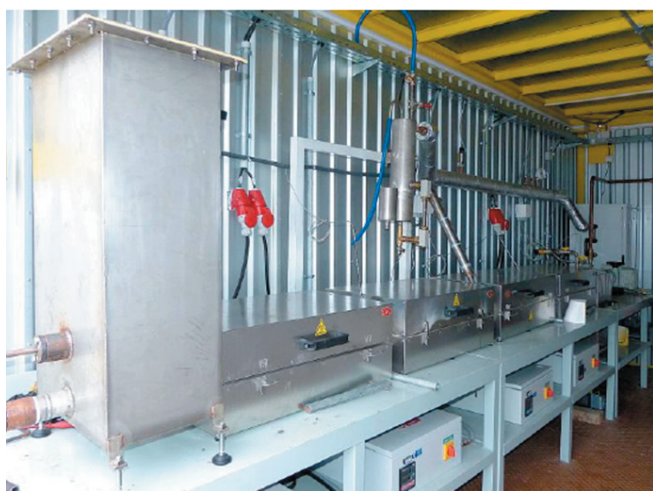
Obr. 1: Pohled na kontejnerovou vývojovou zkušební linku VÚZT, v.v.i. Praha - PolyComp, a.s. Poděbrady s výkonností 2 kg.h -1 vstupního materiálu
