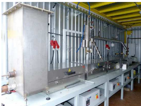
Obr. 19: Pohled na řešení vývojové zkušební linky dvoustupňové termolýzy s výkonností do 2 \text{ kg}\cdot\text{h}^{-1} vstupní suroviny v PolyComp, a.s. Poděbrady
