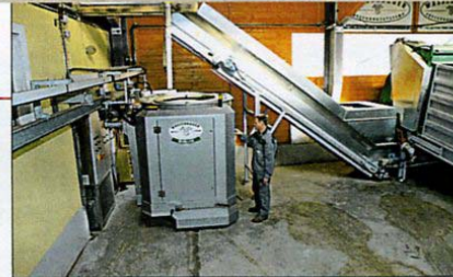
Řada paralelně umístěných mezizásobníků je podle potřeby průběžně doplňována krmivem. V době přípravy krmné směsi jsou jednotlivé komponenty krmné dávky plněny příčným dopravníkem do krmicího robota s vertikálním šnekem, který řídí množství jednotlivých krmiv podle stanovené receptury (řešení firmy Wasserbauer)
