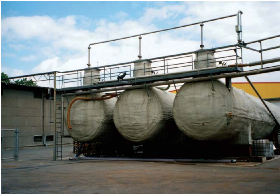
Obr. 27: Zásobníky na výrobu bioplynu z odpadních brambor
