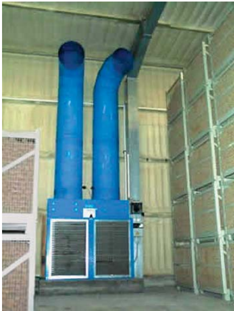
Obr. 30: Integrovaná vzduchotechnická jednotka s nuceným chlazením a zvlhčováním pro paletové sklady (výrobce Agroel Dobrovice s. r. o., ČR)
