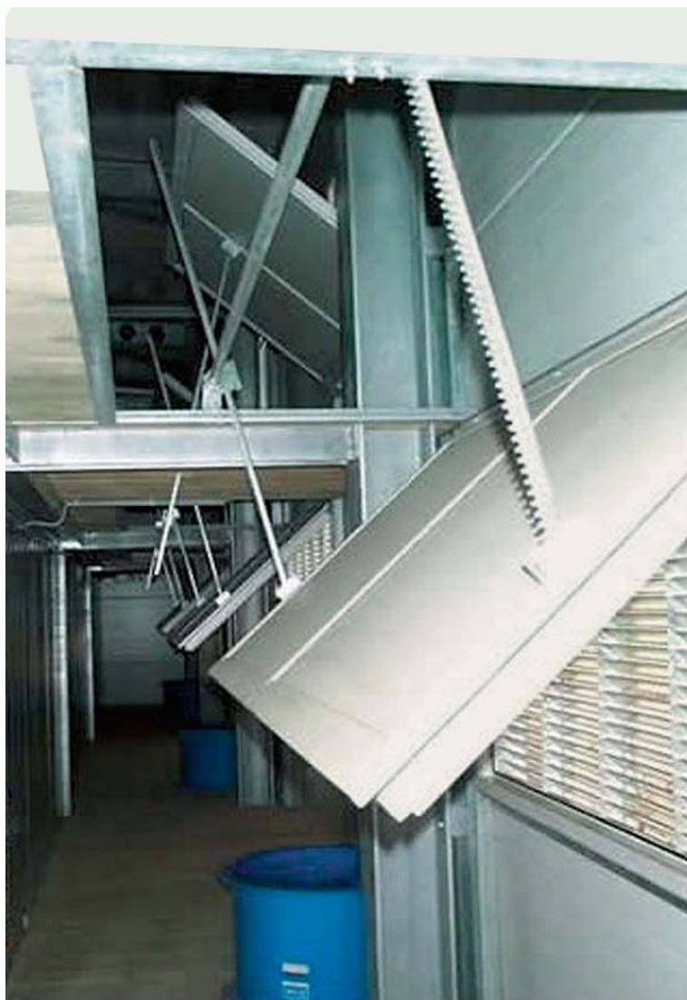
Obr. 28: Vzduchotechnická klapka s automatickým ovládáním (Agroel Dobrovice s. r. o., ČR)
