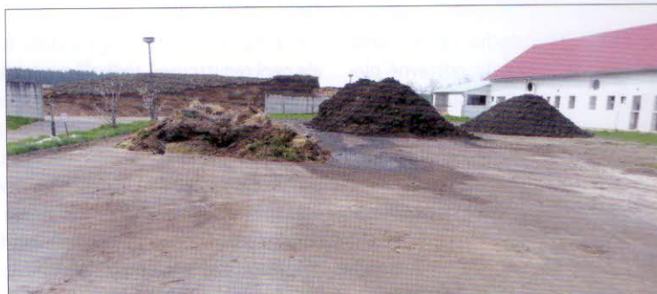
Kompostovací plocha – vodohospodářsky zajištěná betonová plocha 55 x 17 m vyspádovaná k odtokovému otvoru opatřenému mřížkou a spojenému se svodem do záchytné jímky
