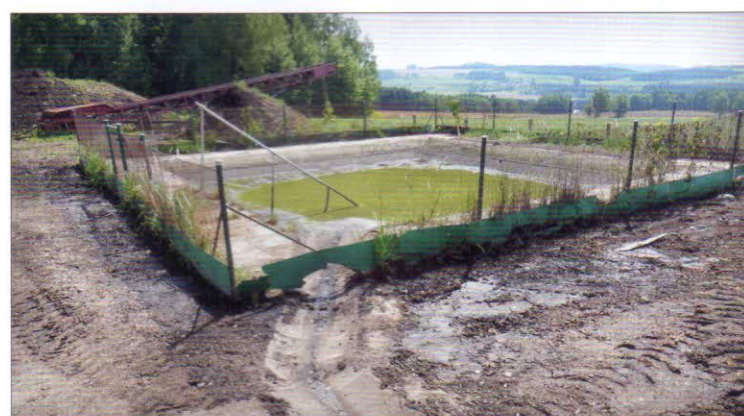
Záchytná jímka je umístěna vedle kompostovací plochy pod úrovní povrchu, jímka je oplocena drátěným plotem. Skladovací kapacita jímky 46 m 3 , její konstrukce je železobetonová
