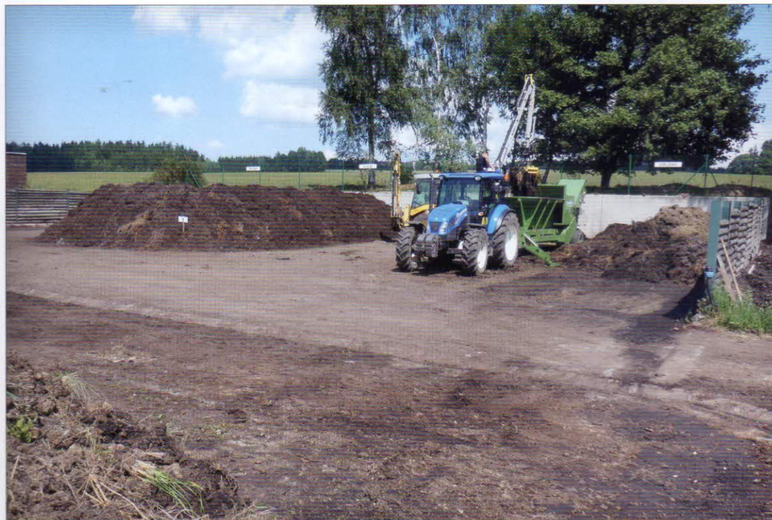
Kompostovací plocha je vodohospodářsky zabezpečena s betonovým povrchem. Celková výměra plochy 1050 m 2 . Plocha je vyspádovaná a voda je z povrchu svedena otevřenými kanálky do záchytné jímky
