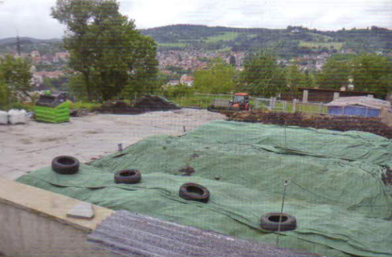
Venkovní kompostovací plocha je rozdělena na dvě části – překopávací (13 x 50 m) a provzdušňovací (12 x 50 m). Kompostovací betonová plocha je vodo hospodářsky zajištěná. Do provzdušňovací plochy jsou zabudovány provzdušňovací kanálky
