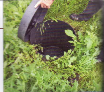
Záchytná jímka – odvod kapalin z kompostovací plochy je vyřešen vypádáním plochy směrem do podzemní záchytné jímky, která je umístěna pod úrovní povrchu hned vedle kompostovací plochy (objem jímky 15 m 3 , plastová obezděná konstrukce)
