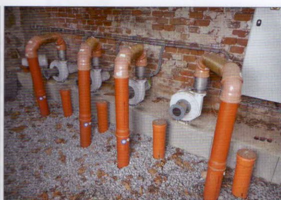
Provzdušňování kompostu – ventiláční jednotka Compost Systems. Vzduch do provzdušňovacích kanálků, které jsou zabudovány přímo do kompostovací plochy, je dodáván z objektu vedle kompostovací plochy, ve které jsou sestaveny všechny ventilátory do jedné centrály. Umístěním ventilátorů do uzavřeného objektu jsou podstatně sníženy jejich hlukové emise, které jsou chráněny před nepřízní počasí, zcizením apod
