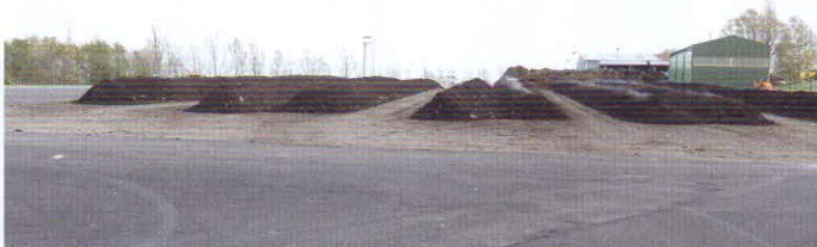
Venkovní kompostovací plocha je vodohospodářsky zabezpečena asfaltobetonovým povrchem; celková výměra plochy 4500 m 2 , tj. 79 x 57 m. Plocha je vyspádovaná, zadržování vod z kompostovací plochy systémem sběrný práh – vpusť – odvodný systém (žlab, potrubí, centrální jímka)
