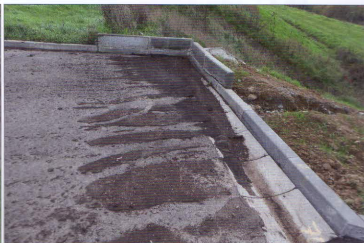
Systém pro sběr vody z kompostovací plochy (vlevo – sběrný práh, vpravo – vpusť do odvodného systému)
