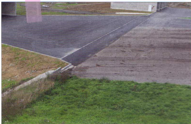
Systém pro sběr vody z kompostovací plochy (vlevo – sběrný práh, vpravo – vpusť do odvodného systému)
