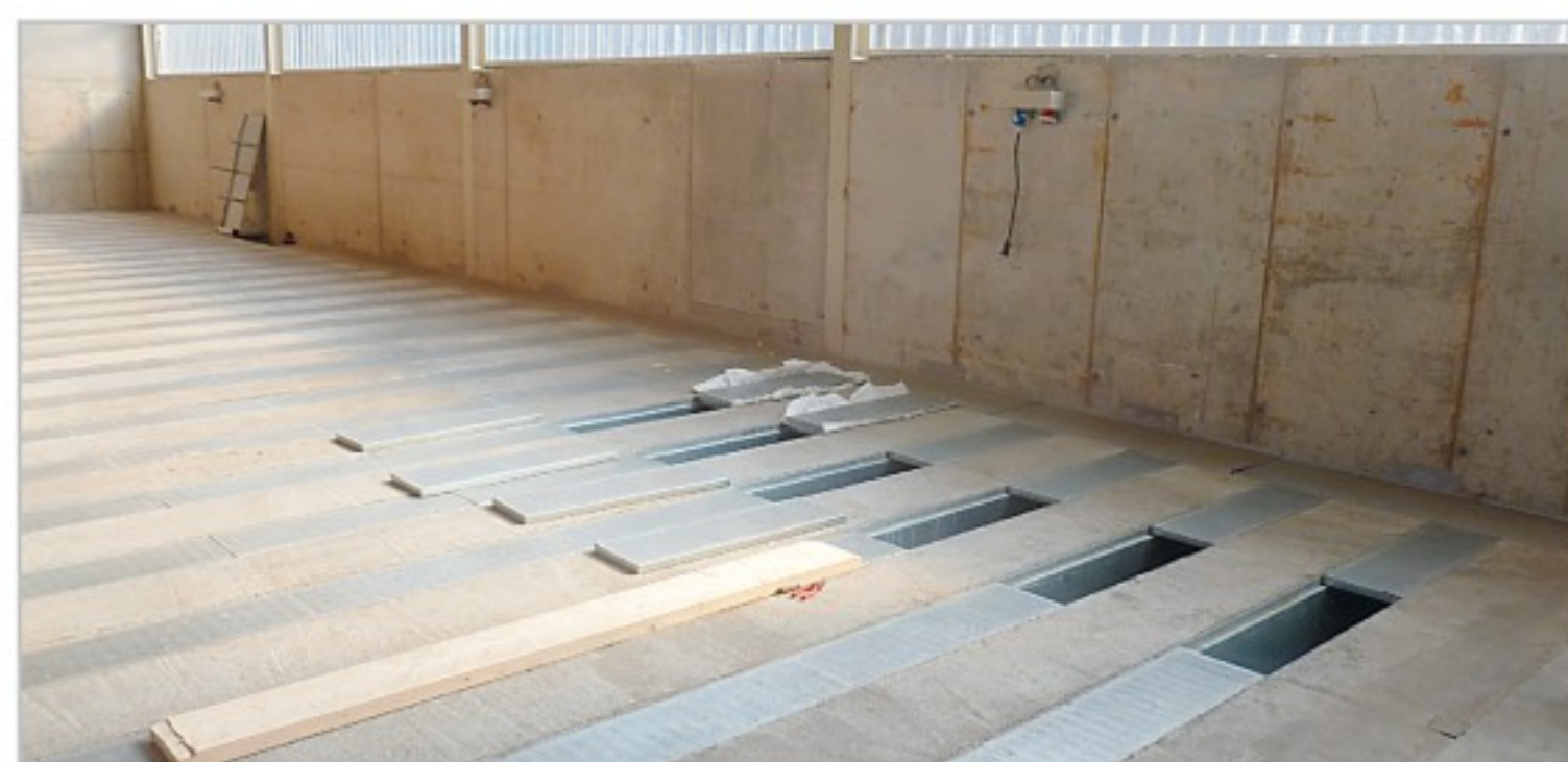
Detail podúrovňových kanálů v halovém skladu pro dosoušení osiva Foto archiv společnosti AGROING BRNO s. r. o.
