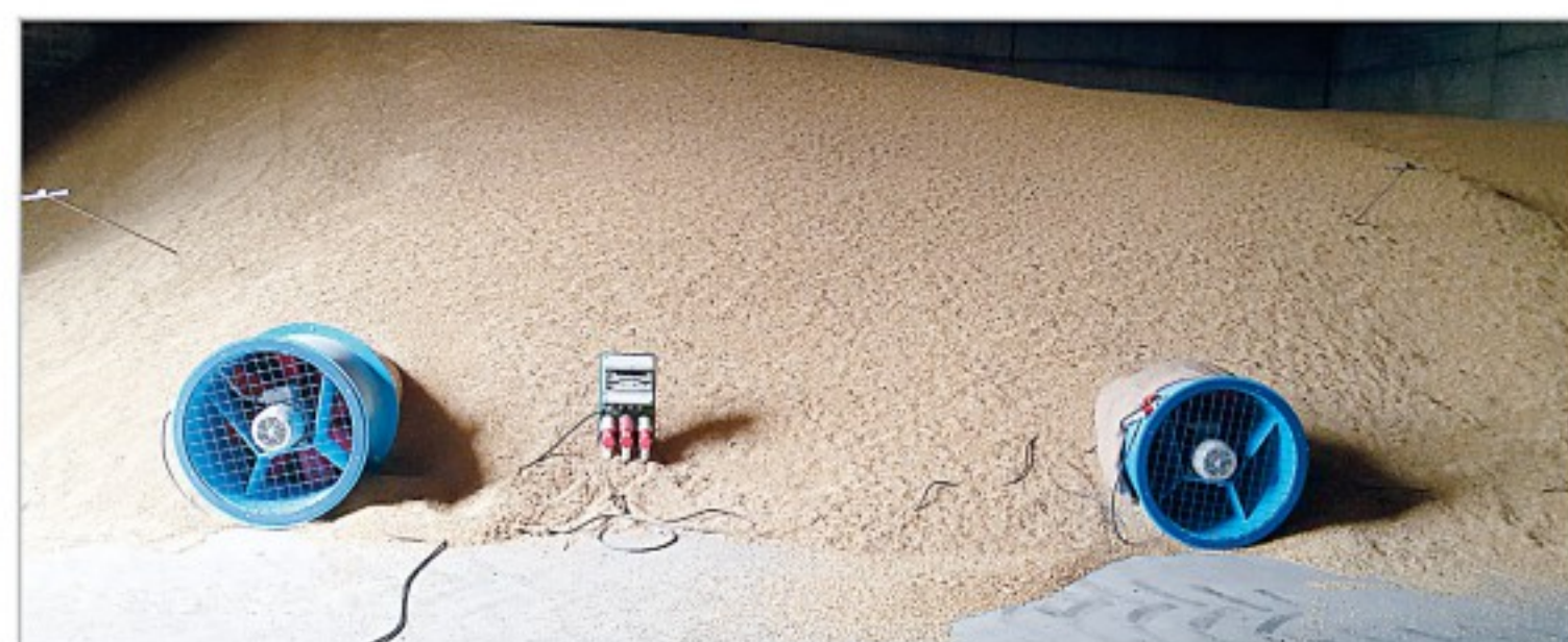
Instalace axiálních ventilátorů na mobilní provzdušňovací systém uvnitř halového skladu Foto archiv autorů článku
