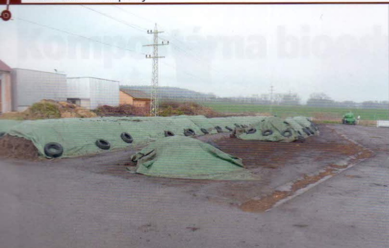
Kompostovací plocha venkovní je vodohospodářsky zabezpečena s asfaltovým povrchem, celková výměra plochy je 3435 m 2 , plocha je podélně vyspádovaná - 2,2 %, hromady jsou příkryvány kompostovacími plachtami
