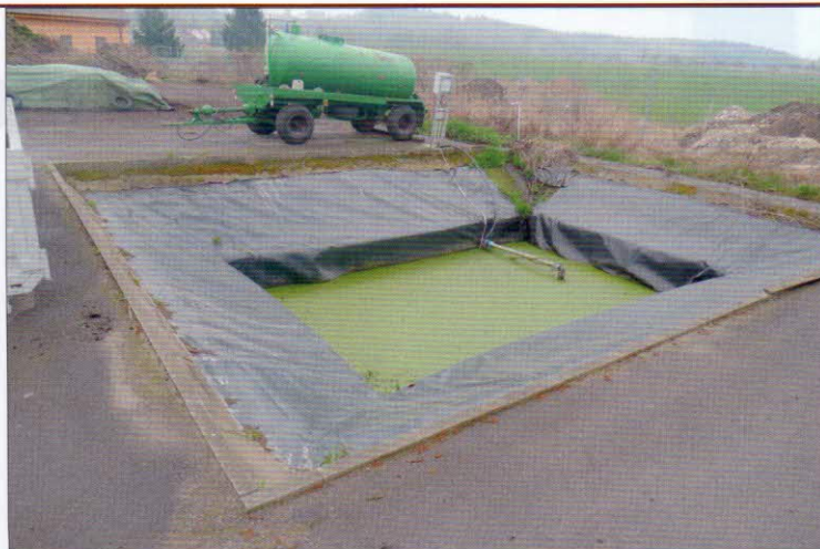
Záchytná jímka železobetonové konstrukce je umístěna vedle kompostovací plochy pod úrovní povrchu s následujícími rozměry: délka - 8,5 m, šířka - 5,5 m, hloubka - 2,5 m, skladovací kapacita - 100 m 3
