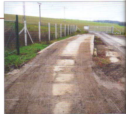
Evidenci přijímaných surovin – silniční mostová váha GRAVEX Steel. Nájezdová váha je nad úrovní vozovky (váživost do 60 000 kg s přesností ± 10 kg)
