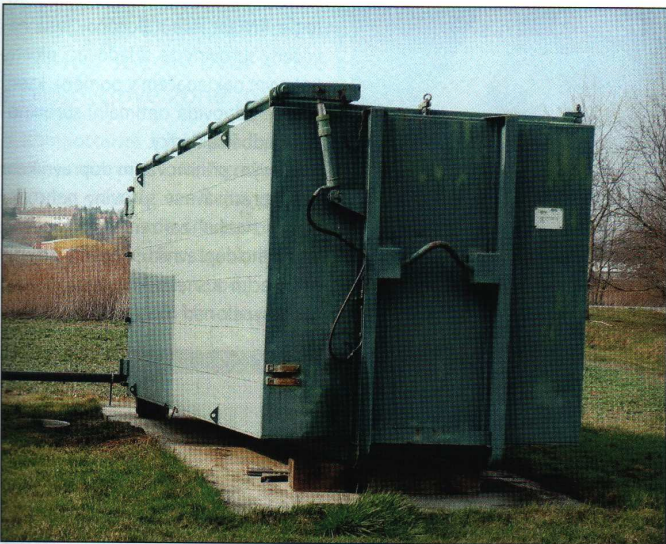
Vzduchotechnická úprava odfuku – biofiltr s pracovním objemem 30 m 3 , náplní je dřevní štěpka a kůra
