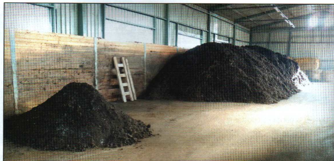
Dozrávání kompostu na vodohospodářsky zajištěné dozrávací ploše uvnitř zastřešené haly (450 m 2 ). Kapacita plochy dosahuje 900 m 3 kompostu
