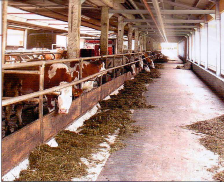
Obr. 8 – Ve stáji je také instalována nosná konstrukce s pojezdovou kolejnicí. Krmný vozík Trioliet zakládá a současně přihruje zbytky krmiva podle programu řízeného počítačem
