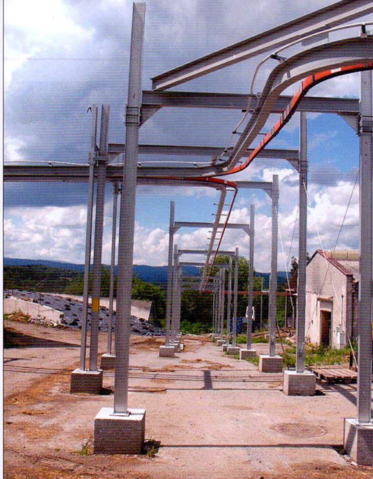
Obr. 7 – Pro pohyb krmného vozíku z meziskladu do stáje slouží kolejnice zavěšená na nosné konstrukci. Vozík dokáže jezdit i do mírného svahu
