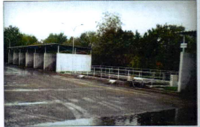
Kompostovací plocha – vodohospodářsky zajištěná asfaltová plocha se svodem do záchytné jímky. Celková velikost plochy 4611 m 2 , objem jímky 205 m 3
