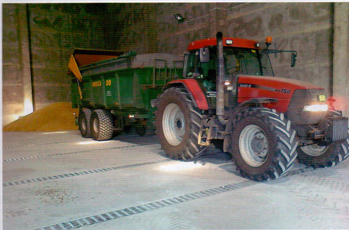
Naskladňování halového skladu vybaveného podúrovňovými přejezdnými provzdušňovacími kanály Foto Jiří Bradna
