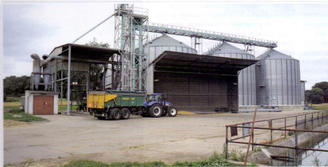
Pohled na posklizňovou linku o skladovací kapacitě 3000 tun
