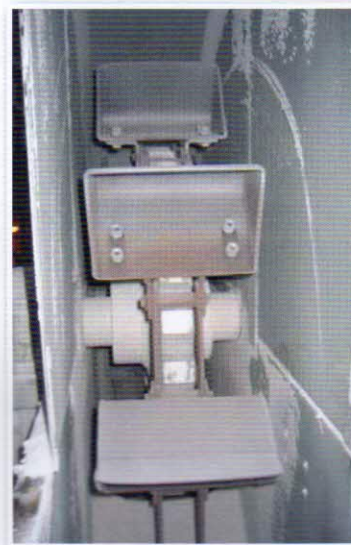
Horní hlava korečkového elevátoru s pohonem Foto Jiří Bradna
