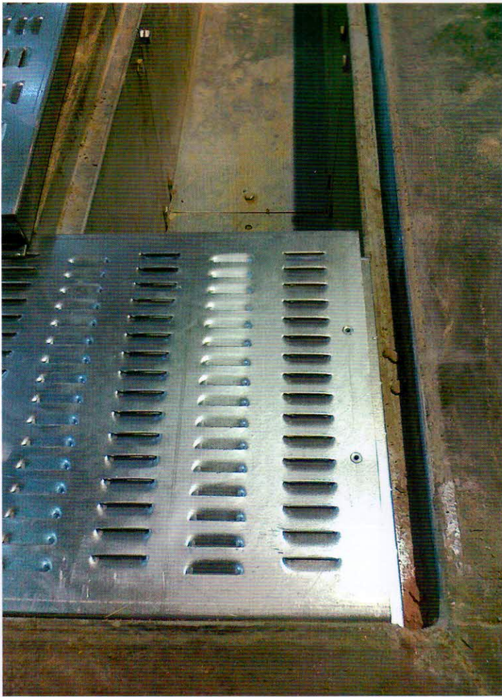
Detail podúrovňového provzdušňovacího kanálu
