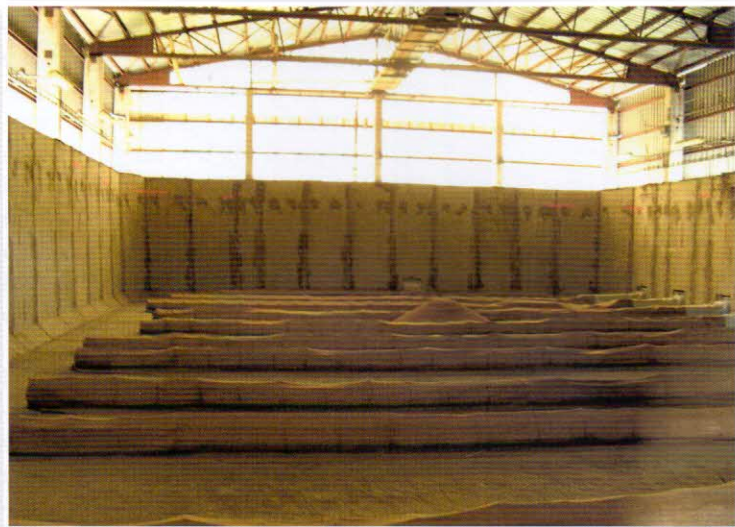
Starší typ nadúrovňových provzdušňovacích kanálů ze stočených drátů pokrytých pytlou v halovém skladu Foto Jiří Bradna
